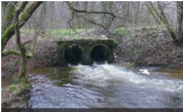
AVANT chantier de restauration de la continuité écologique
