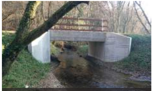
APRÈS chantier de restauration de la continuité écologique
