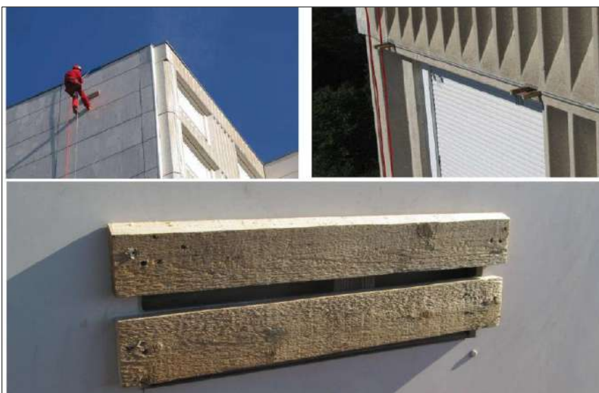
Intégration d'un gîte de substitution en façade d'immeuble à Besançon (25), avant colmatage des accès aux joints de dilatation et vides sanitaires qui permettaient à une colonie de Pipistrelles de rejoindre les cloisons intérieures (Attention dans ce type de dispositif à bien veiller à l'absence de nuisance pour les habitants). (Sources : CPEPESC Franche-Comté)
