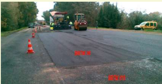
Photo 20 : La pose du BBT-M06 a été intégrée dans une opération de rénovation déjà programmée (Source : CD 13/Groupe Chiroptères de Provence)
