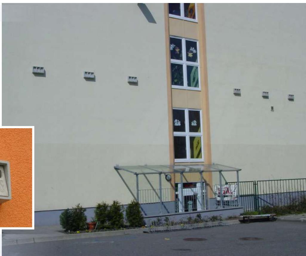
Nichoir à moineaux encastré dans l'isolation extérieure
