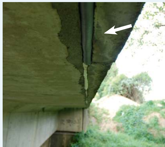
Photo 19 : Cavité bouchée à l'aide de gaine d'isolation de tuyau de chauffage (Source : S. Bareille)
