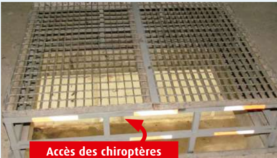
Photo 130 : Grille d'aération rehaussée (Source : Vinci Autoroutes/réseau ASF/Nature Midi-Pyrénées)
