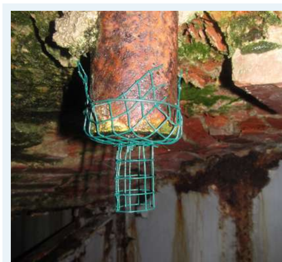
Photo 17 : Exemple de dispositif anti-retour utilisé dans le cadre de la réfection d'un ouvrage d'art (Source : CPEPESC Franche-Comté)
