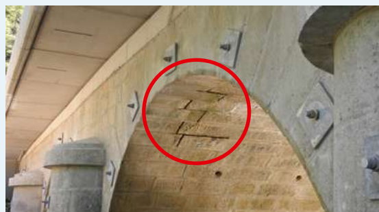
Photo 133 : Interstices non rejoints lors des opérations d'entretien de l'ouvrage (Source : CPEPESC Franche-Comté)
