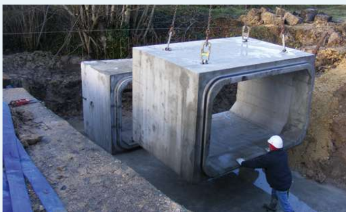
Photo 104 : Mise en place des modules préfabriqués
