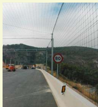
Photo 38 : Dispositif de filet anti-collision (Source : CADEC, Taller de Gestión Ambiental S.L.)
