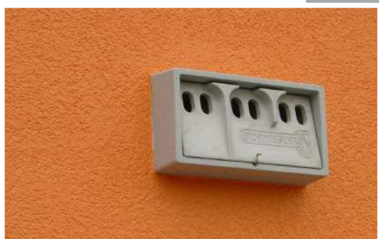
Nichoir à moineaux encastré dans l'isolation extérieure
