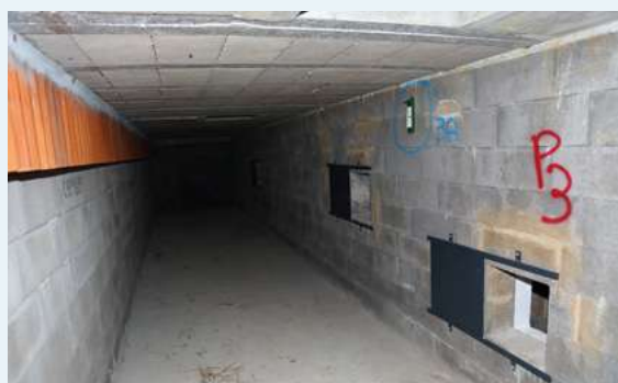
Photo 95 : Ouvertures de régulation thermique (Source : CPEPESC Lorraine)
