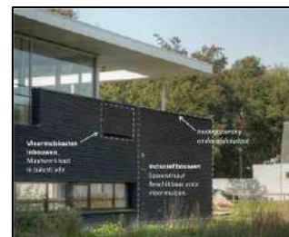
Exemple de structure d'accueil pour les chauves-souris derrière le bardage d'une construction récente (Sources : Landschaftsbeheer Flevoland)
