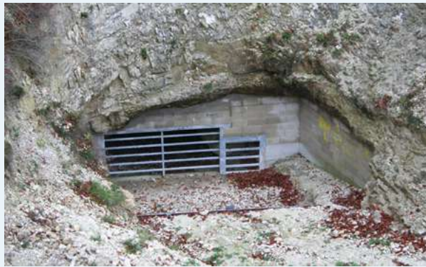
Photo 96 : Pose d'une grille à l'entrée de la cavité d'Allonne dans le cadre de la réalisation de la déviation Sud de Beauvais (RN31) (Source : CEN Picardie)
