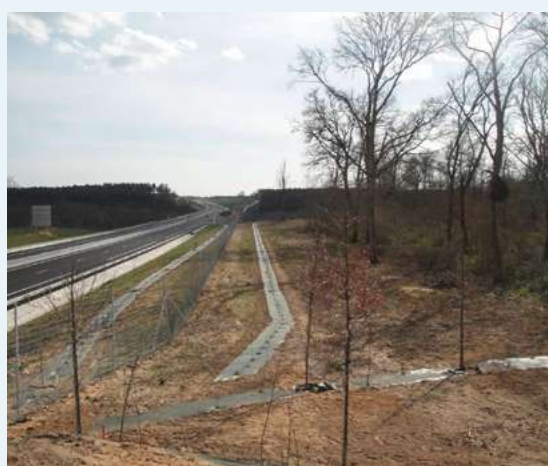
Photo 63 : Plantation, jusqu'à l'ouvrage, d'une double haie de guidage le long de l'autoroute A65 (Source : A'Liéonor/Eiffage)
