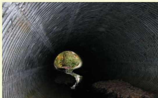
Photo 46 : Buse métallique de diamètre 2 m (Source : Cerema - Est)
