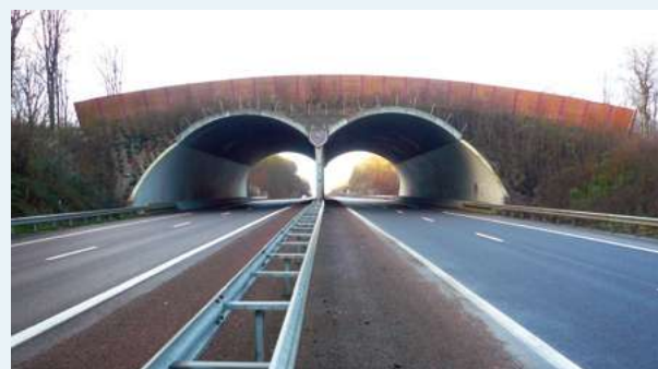
Photo 77 : Écran d'occultation sur un ouvrage supérieur de la RN 2 - Forêt de Retz (Source : DIR Nord)
