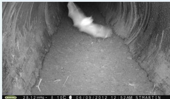
Photo 124 : Passage d'un Chiroptère dans une buse de 800 mm de diamètre, 65 m de longueur, réalisée sous l'A64. Cliché obtenu environ 3 mois après l'achèvement de l'éco-duc (Source : Nature Midi-Pyrénées/Vinci Autoroutes/réseau ASF, 2012)
