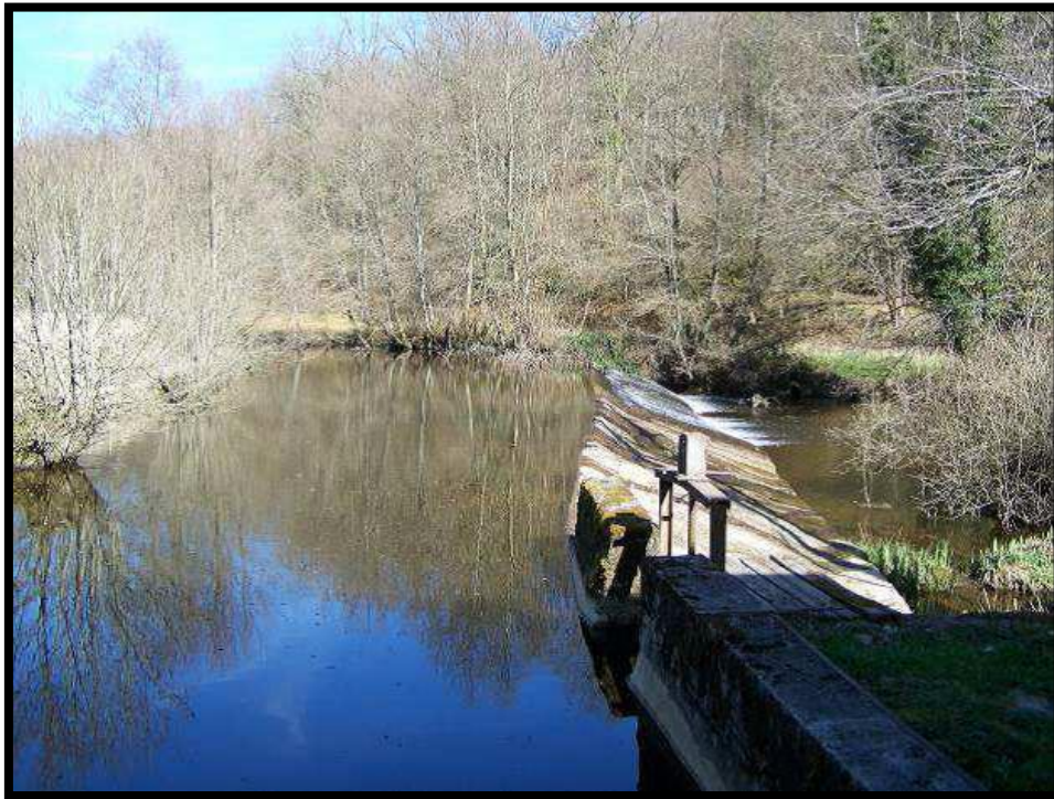
Figure 54 Vue du seuil du moulin de Grandcoing depuis le plan de grille
