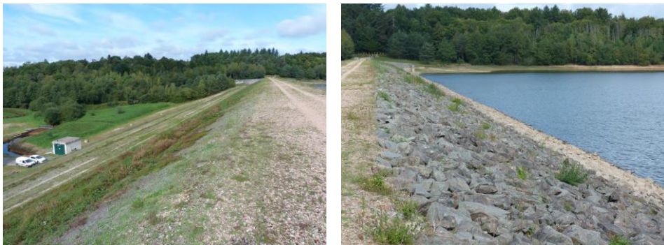
Figure 85 Photographie du barrage de Mialet (source : DREAL Nouvelle-Aquitaine)
