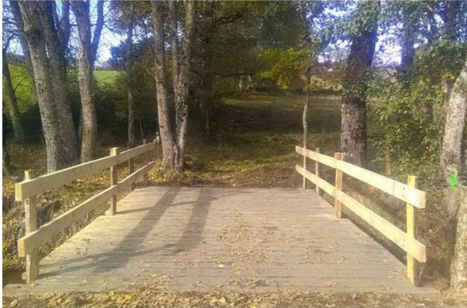
Réalisation d'une passerelle pour le franchissement d'un cours d'eau (EPTB Viaur)
